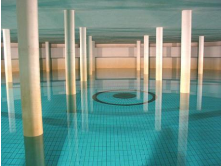
Trinkwasser-Hochbehälter Brüsselweg (Foto: Stadtwerke Hameln).
