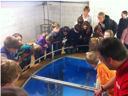
Brunnen im Wasserwerk II / Kinderuni 2012 (Foto: Stadtwerke Hameln).
